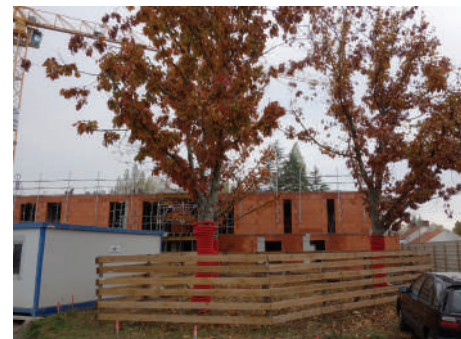
Dispositif de protection des arbres
